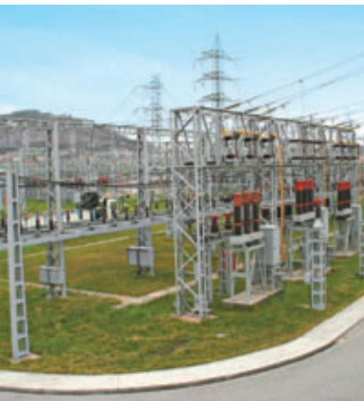
Un sistema de transmisión de energía de una ciudad tiene la función de bajar el voltaje para poder ser distribuido a los hogares.
