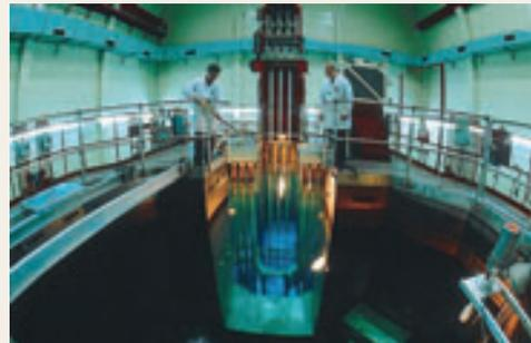
En la fotografía se aprecian las barras de combustible del reactor RECH-1, al ser introducidas en la piscina. Allí, en el núcleo del reactor, sumergido a 10 metros en el agua, se produce la fisión controlada del uranio.
